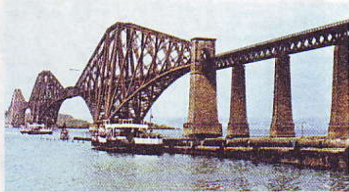
Мост Фаулера и Бейкера над заливом Форт. Длина 1,6 км
