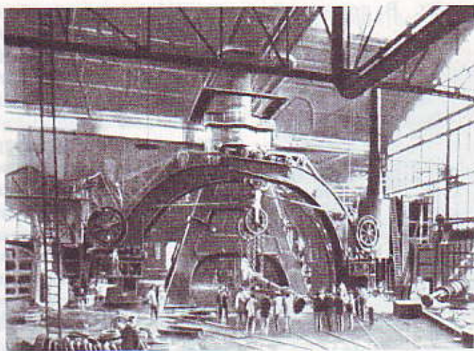
Тяжелая промышленность во Франции в конце XIX в. Паровой молот весом 100 т на заводе Крезе
